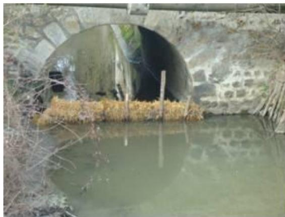
Figure 13: Barrage filtrant constitué de ballots de paille – Travaux sur l'Orge aval (91) – Conception et MO : CIAE.
