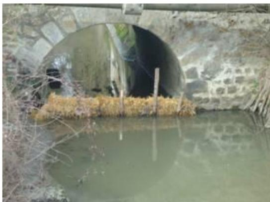
Figure 6: Exemple de barrage filtrant constitué de ballots de paille – Travaux sur l'Orge aval (91) – Conception et MO : CIAE.
