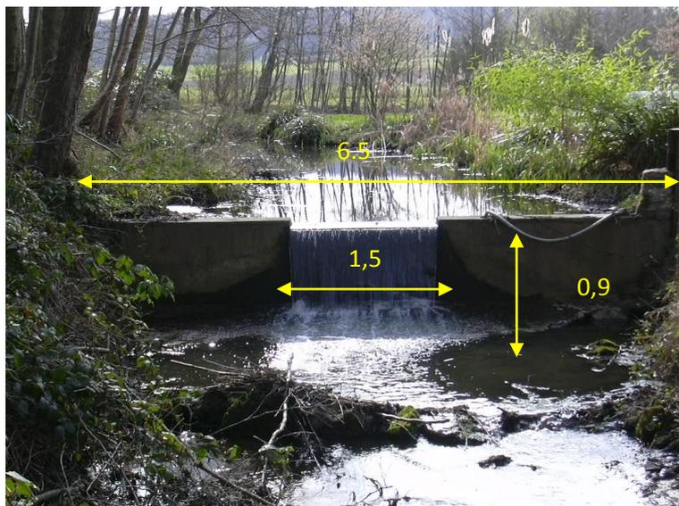
Figure 4: photographie de l'ouvrage O14
